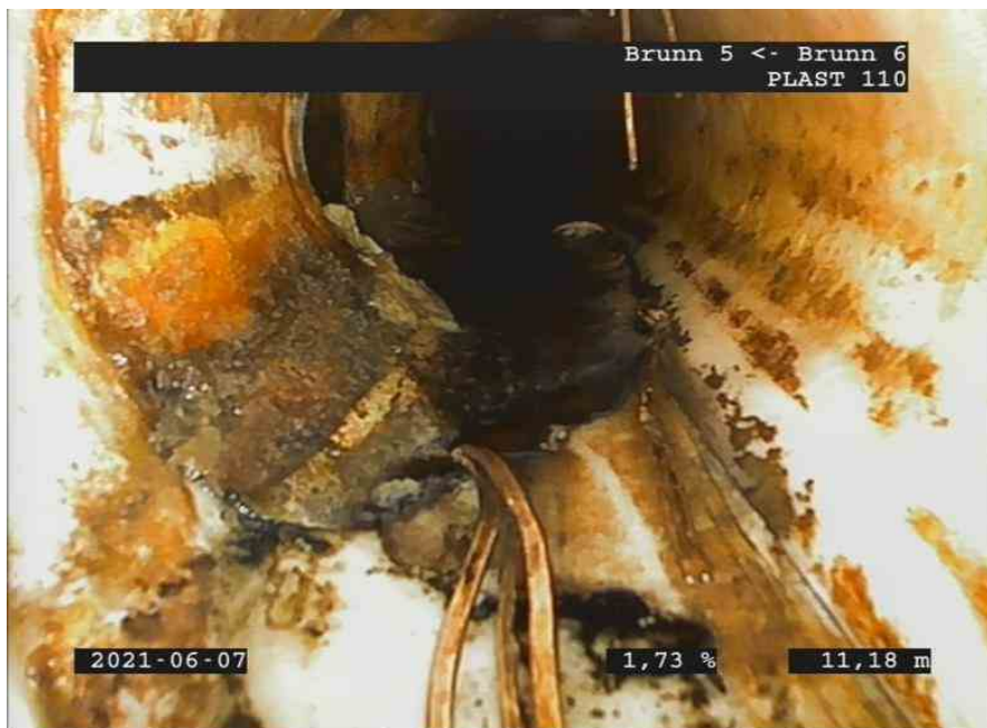
Brunn 6Brunn 507062113285A.jpg, 00:04:02, 11.18m Produktionsfel 2. Felets utbredning är mindre än 2 timmar och beläget under rörets hor. mittlinje, Cirkulär från 5 till 7
