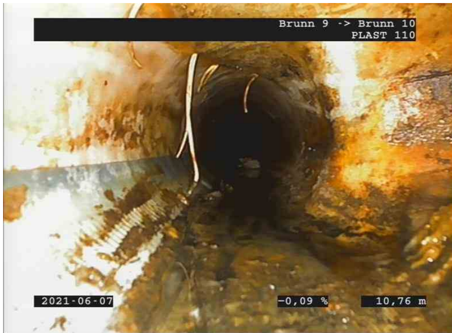
Brunn 9Brunn 1007062115092B.jpg, 00:01:44, 10.76m Produktionsfel 1. Felet medför en reduktion av tvärsnittsarean mindre än 5 %, Cirkulär från 11 till 1
