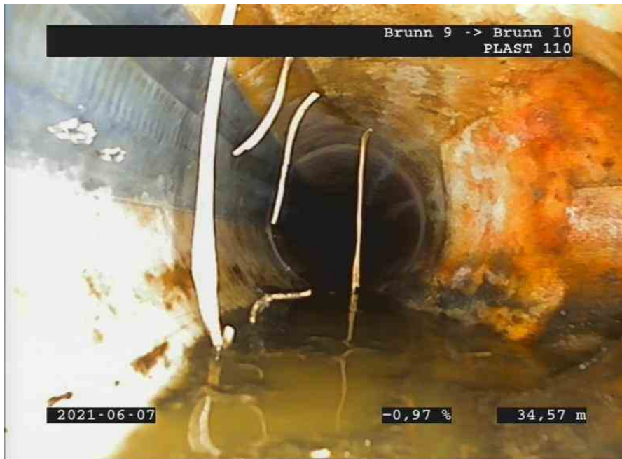
Brunn 9Brunn 1007062115096B.jpg, 00:07:26, 34.57m Produktionsfel 1. Felet medför en reduktion av tvärsnittsarean mindre än 5 %, Cirkulär
