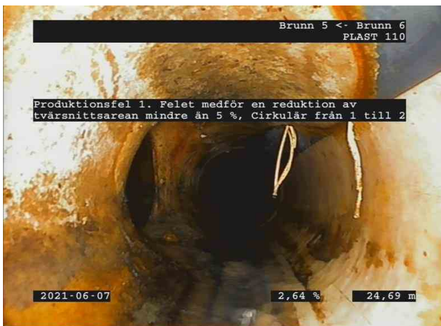
Brunn 6Brunn 507062113287B.jpg, 00:09:11, 24.69m Produktionsfel 1. Felet medför en reduktion av tvärsnittsarean mindre än 5 %, Cirkulär från 1 till 2
