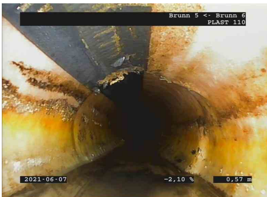
Brunn 6Brunn 507062113283B.jpg, 00:00:51, 0.63m Produktionsfel 1. Felet medför en reduktion av tvärsnittsarean mindre än 5 %, Cirkulär från 11 till 2
